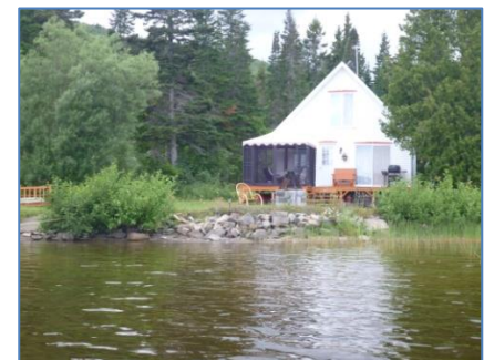
Figure 12. Stabilisation de la rive en pierre
