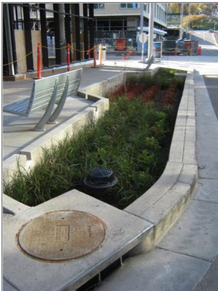
Aire de biorétention en milieu urbain Portland. Photo : N. Bédard
