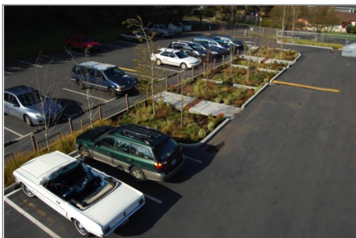
Aire de stationnement avec biorétention, Portland. Photo : N. Bédard
