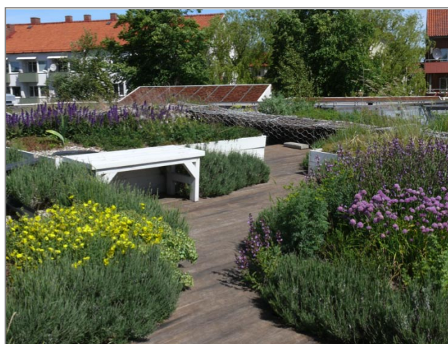
Exemple de toit vert intensif en Suède. Aménagement de fines herbes et vivaces, Architecte paysagiste Par Söderblom Photo : P. Stahre
