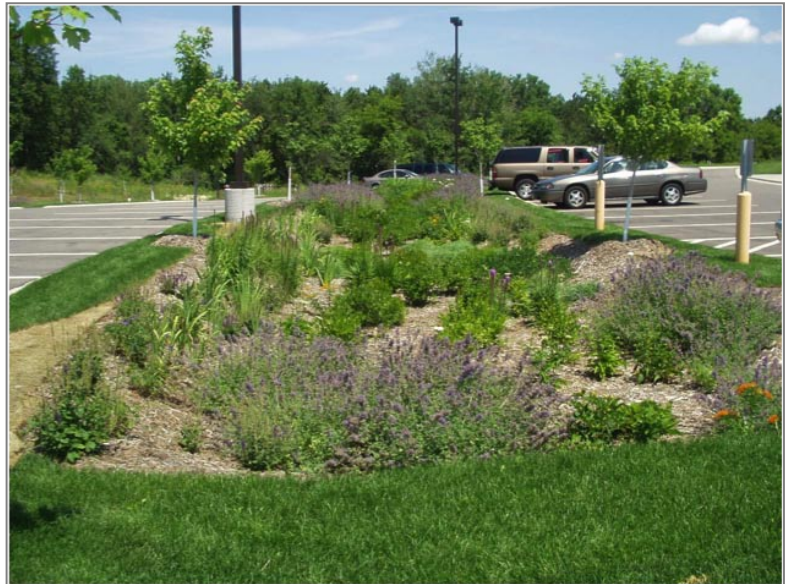
Aire de biorétention pour un stationnement commercial, Washington County South Service Center in Cottage Grove, Minnesota. Photo : Washington Conservation District
