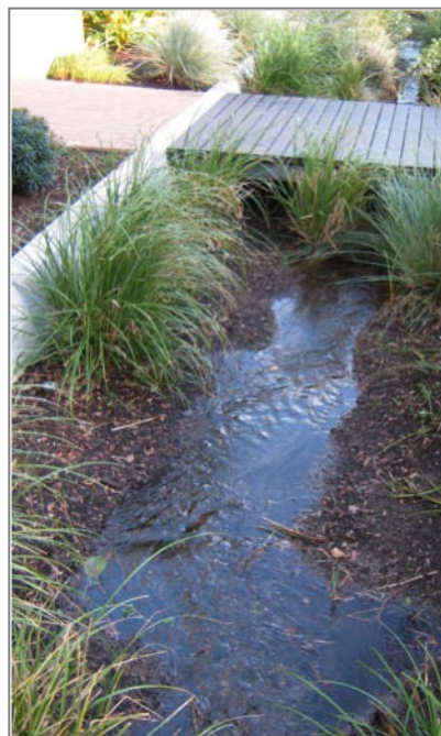
Fossé végétalisé pouvant recevoir un plus fort débit d'eau, Portland. Photo : N. Bédard
