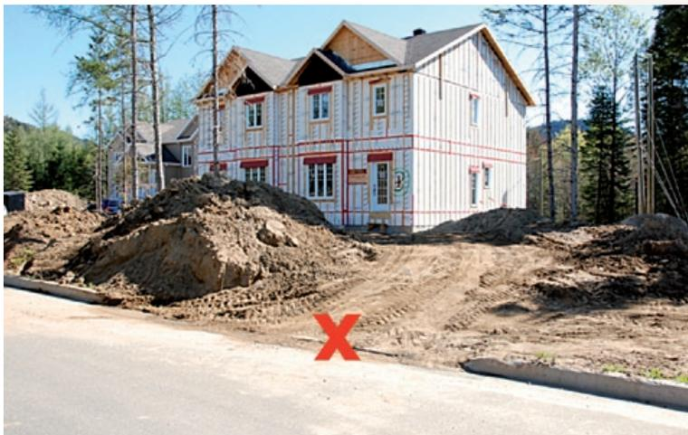
Figure 4 – Accès au chantier sans stabilisation
