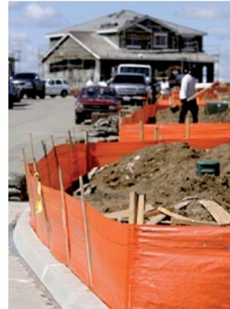
Figure 2 – Barrière à sédiments<sup>1</sup>
