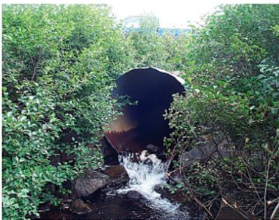
**Un ponceau trop étroit et mal installé peut être un obstacle insurmontable pour les poissons.**
