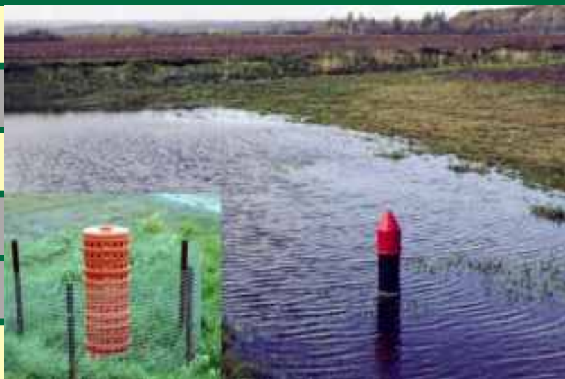
Avaloir et bassin de sédimentation
