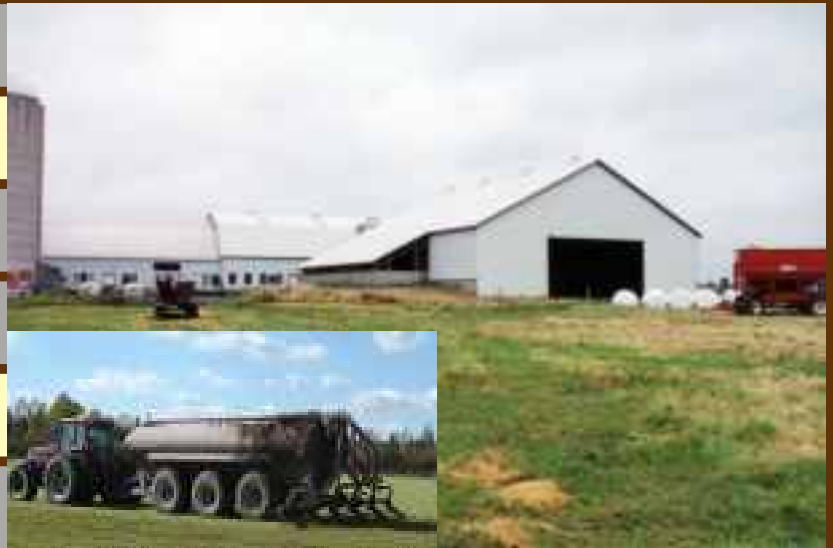
Ouvrage de stockage couvert et rampe d'épandage avec incorporation
