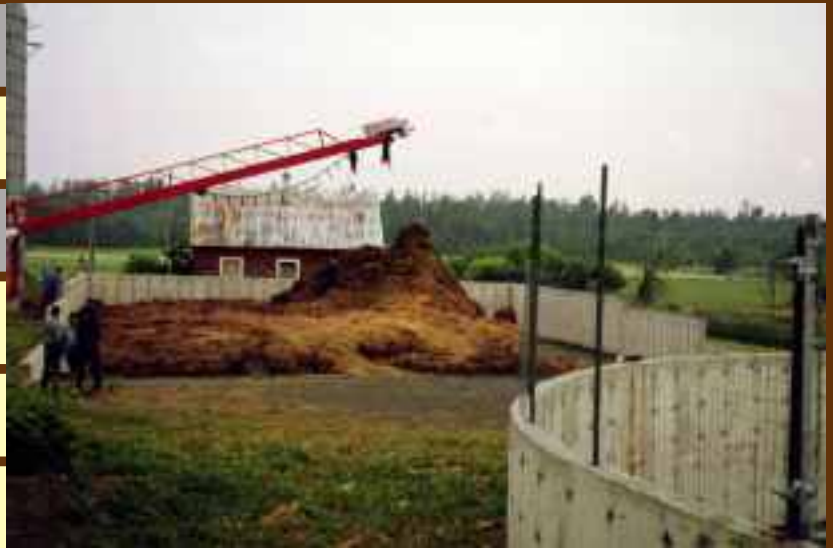
Ouvrage de stockage pour le fumier solide
