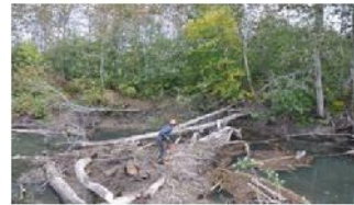
Figure 28. Sectionnement de l'embâcle
