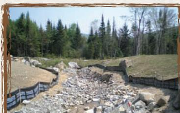
Les **mesures de contrôle des sédiments** sont **variées**. Parmi ces méthodes correctives, on retrouve entre autres les **bassins de sédimentation** et les **barrières à sédiments**. Pour être efficaces, ces mesures doivent être installées de manière adéquate et bien entretenues.
